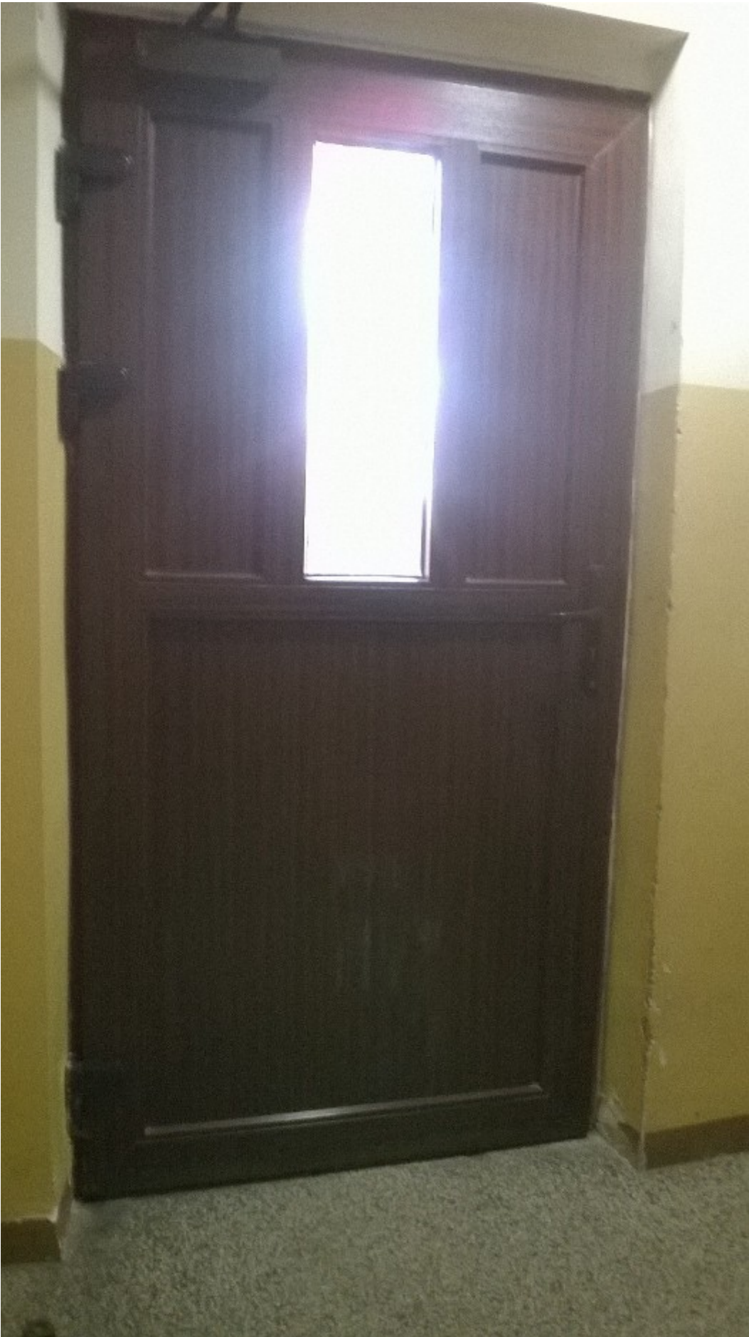
Widok drzwi od strony klatki schodowej
